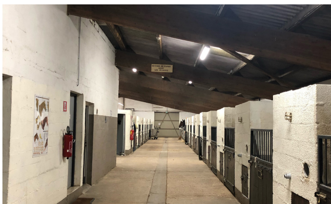
Éclairage optimisé dans les allées de circulation
