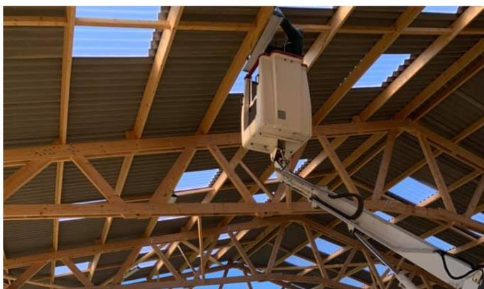
Montage simple et rapide en applique sur les pannes de la charpente
